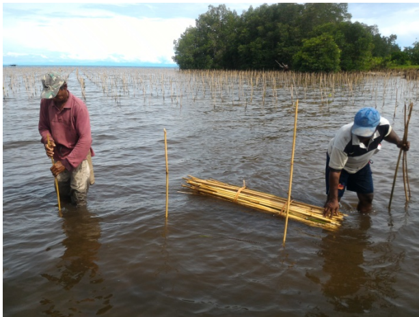
Gambar 53. Pemasangan Ajir (Foto: Iwan Hamid)
