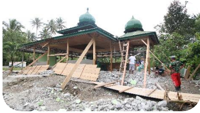
Proses pembangunan Mushola Al Ikhlas di Dusun 2 Kekea
