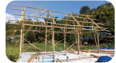
Proses pembangunan Ruang Ramah Anak di dusun 2 Luro
