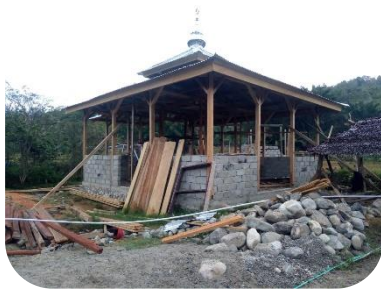
Proses pembangunan Mushola Al Falaq di Dusun 2
