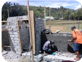
Proses pembangunan MCK Komunal di dusun 2 Luro
