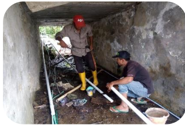
Proses pemasangan pipa air di dusun 2 Luro
